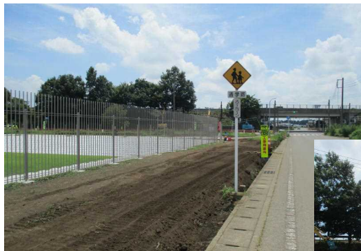
変わりゆく周辺道路 工事中の登下校に 気を付けましょう。
